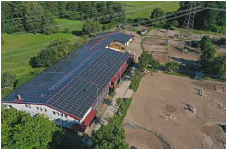
400 kWp erbringt diese Anlage
