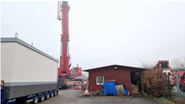
50 Tonnen müssen vom Gelände des Wertstoffhofes auf die vorbereitete Plattform beim Klärwerk gehievt werden. Für den Kran kein Problem, er kann das Zehnfache heben.
