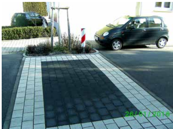
Bepflasterung der Rastatter Straße
