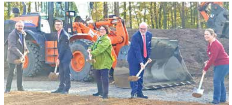
Startschuss für die Bauarbeiten zur Gasverdichterstation: Nils Höger (Projektleitung terranets bw), OB Sebastian Schrempp, Katrin Flinspach (Geschäftsführerin terranets bw), Dirk Güsewell (Aufsichtsratsvorsitzender terranets bw) und Susanne Kurschat (Projektleitung terranets bw) beim Spatenstich.
