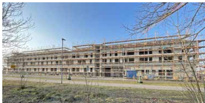
Der imposante Rohbau des neuen ASB-Seniorenzentrums soll einen klingenden Namen bekommen. Foto: S. Nagel
