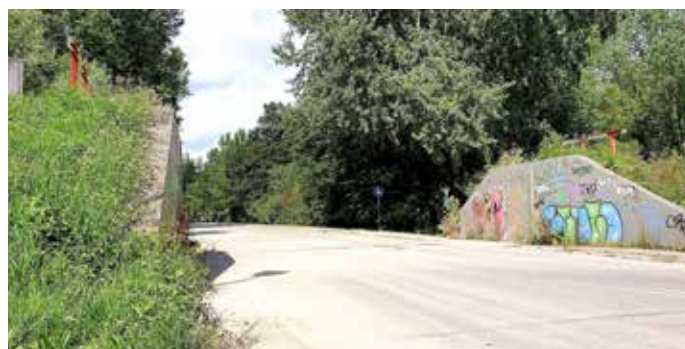
Trennbauwerk: der Hochwasserdamm HWD XXV in Neuburgweiler
