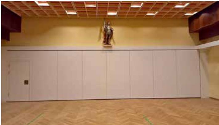
Neue Trennwand Saal Bernhardushalle
