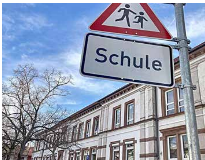
Hat das Gebäude eine Zukunft? Die ehemalige Hebelschule in der Rastatter Straße soll nach dem Siegerentwurf des Architektenwettbewerbs für eine neue Ganztagsgrundschule in Mörsch abgerissen werden. Foto: Julia Trauden
