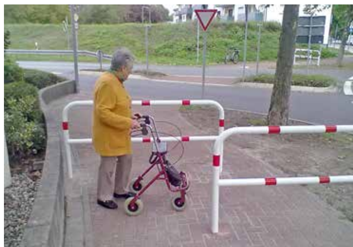
Z-Schranke, Drängelgitter, Umlaufsperr
