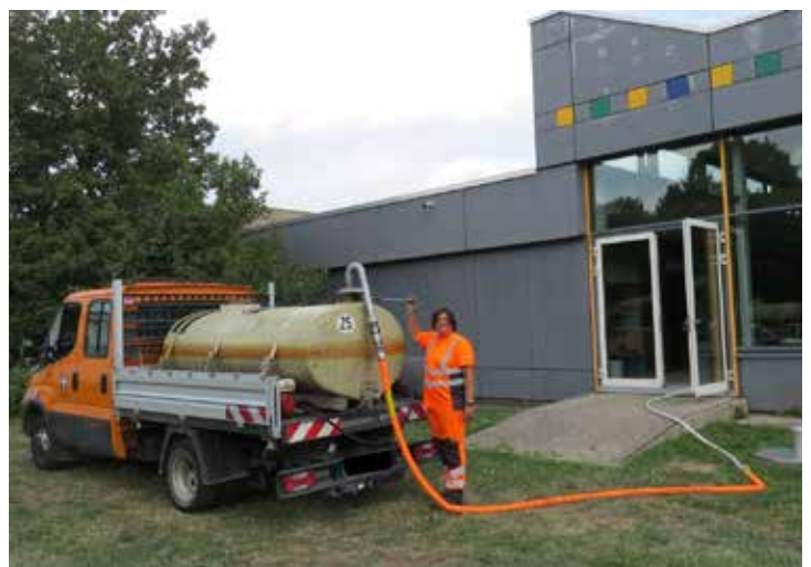
Mitarbeiterin Nicole Rapp beim Abpumpen des Hallenbadwassers
