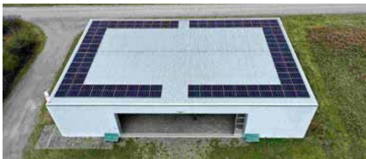
Die neue PV-Anlage auf der Halle 2
