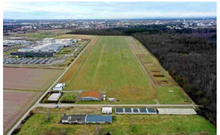
Die beiden PV-Anlagen auf den beiden Dächern der Gebäude der LSG.
