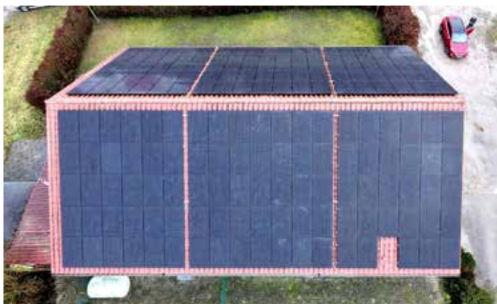
Luftbild von der neuen PV-Anlage
