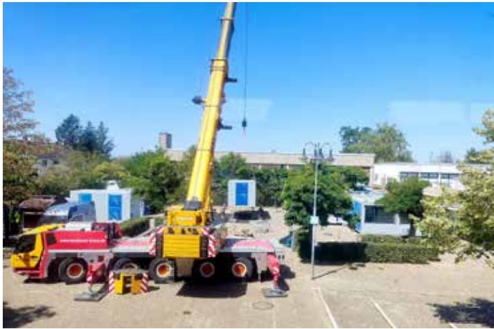
Aufstellung der Container
