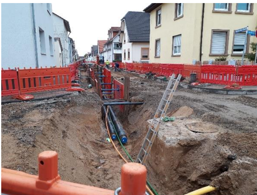
Bauabschnitt 3: Verlegung der Fernwärme / Friedrich-Ebert-Straße / Kreuzung Sofienstrasse
