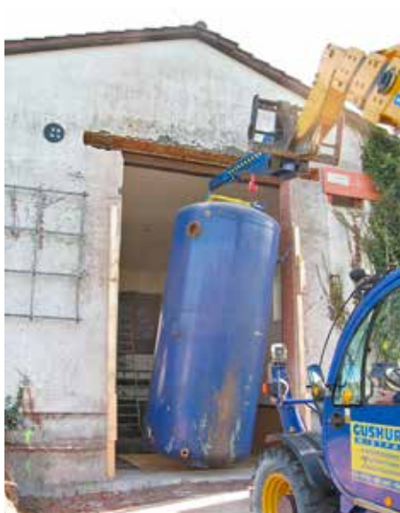
Die alte Filteranlage im Wasserwerk Neuburgweiler wurde ausgebaut und durch eine neue Anlage ersetzt.
